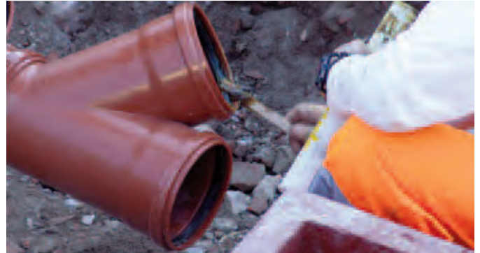
Lubrificazione della guarnizione / Seal lubrication
