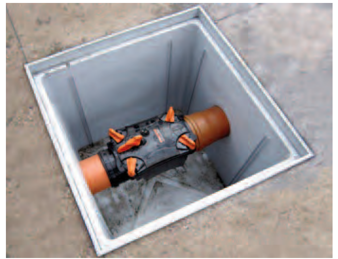
Ottima valvola antiriflusso installata in pozzetto di ispezione Ottima NVR inside an inspection chamber
